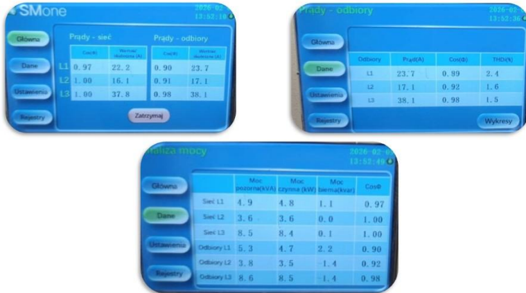
Rys 5. Zdjęcia pracującego kompensatora mocy bierniej
