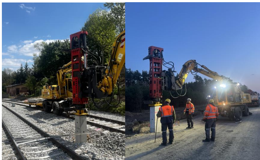
Rys. 1. Zabudowa fundamentu palowego z wykorzystaniem palownicy MOVAX na koparce dwudrogowej Atlas.
